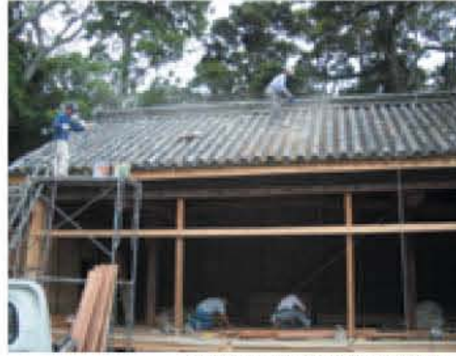
林崎農村舞台(阿南市)の改修工事
